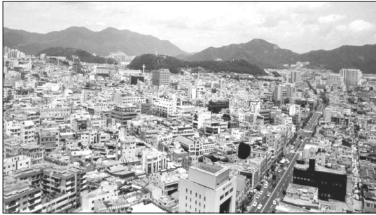
〈그림 2〉 주택과 상업용 건물이 혼재된 도심 주택지구 전경 (부산시 남구 문현동 일원)
